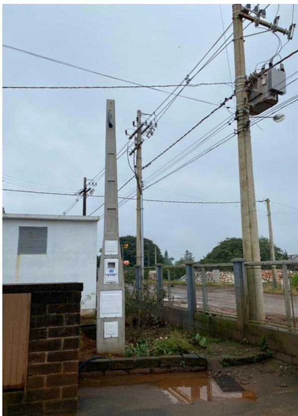
Ao longo do processo de instalação e implementação das melhorias, houve uma reformulação do quadro elétrico e redistribuição das cargas do sistema elétrico para otimizar a operação do sistema de geração. Além disso, foi selecionado um local estratégico para a instalação do banco de capacitores, visando à correção do fator de potência.
